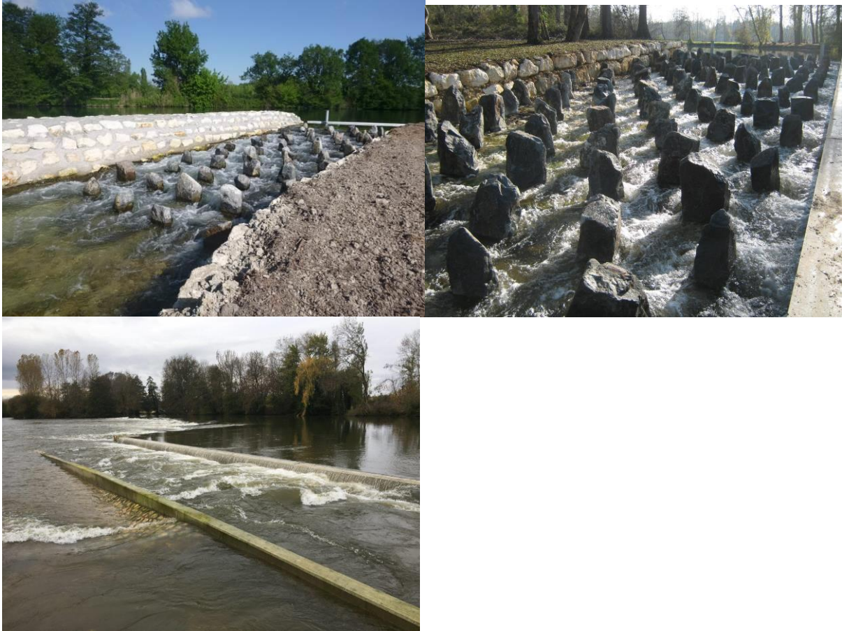
Figure 12 : Passes à poissons réalisées par le Département de la Charente
