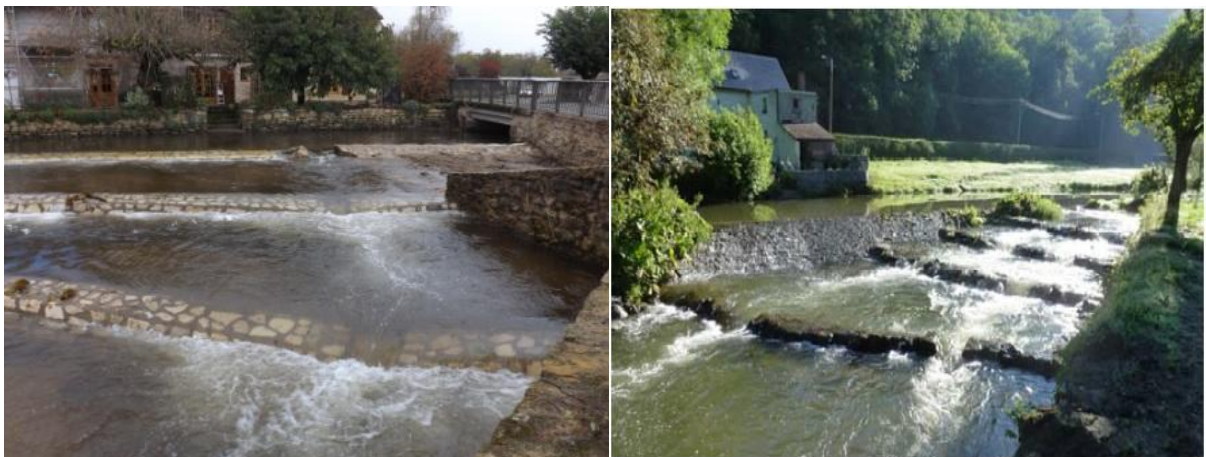
Photo 2 : Vue de seuils triangulaires avec échancrure et de pré barrages
