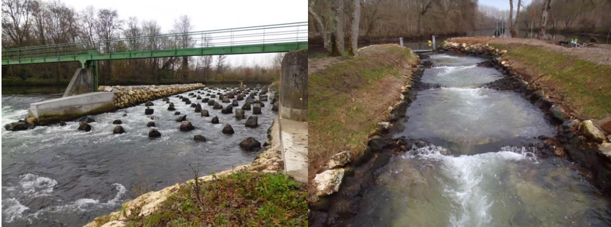
Photo 3 : Vue d'une rampe en enrochements régulièrement répartis et d'un bras de contournement avec seuils triangulaires (SEGI)
