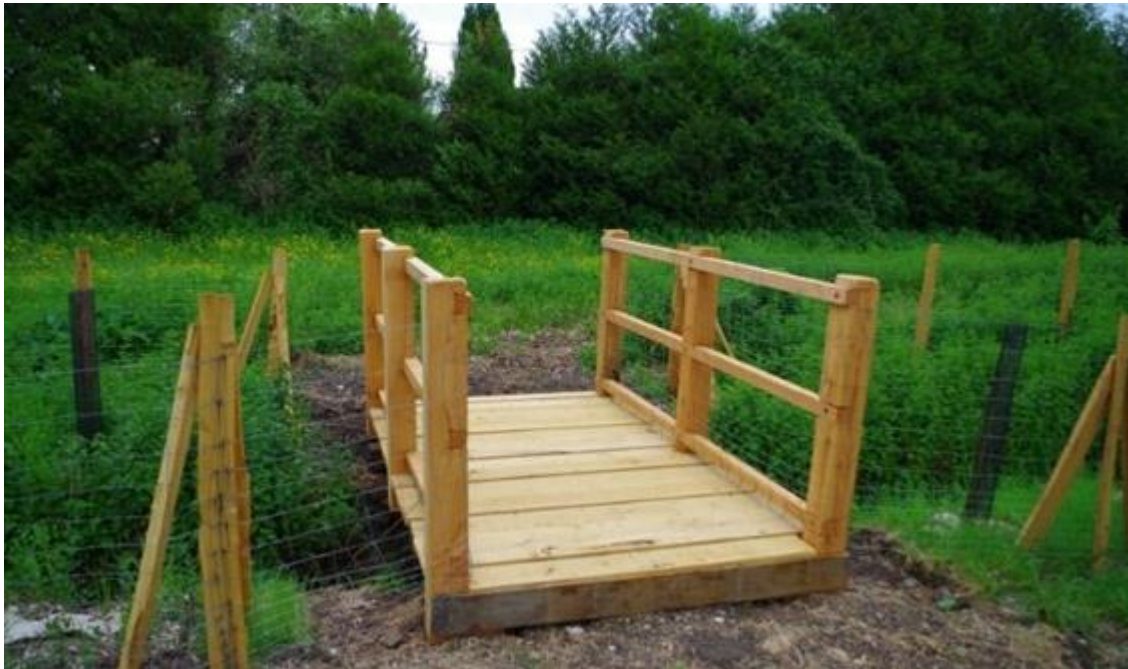
Exemple de passerelle pour le bétail)
