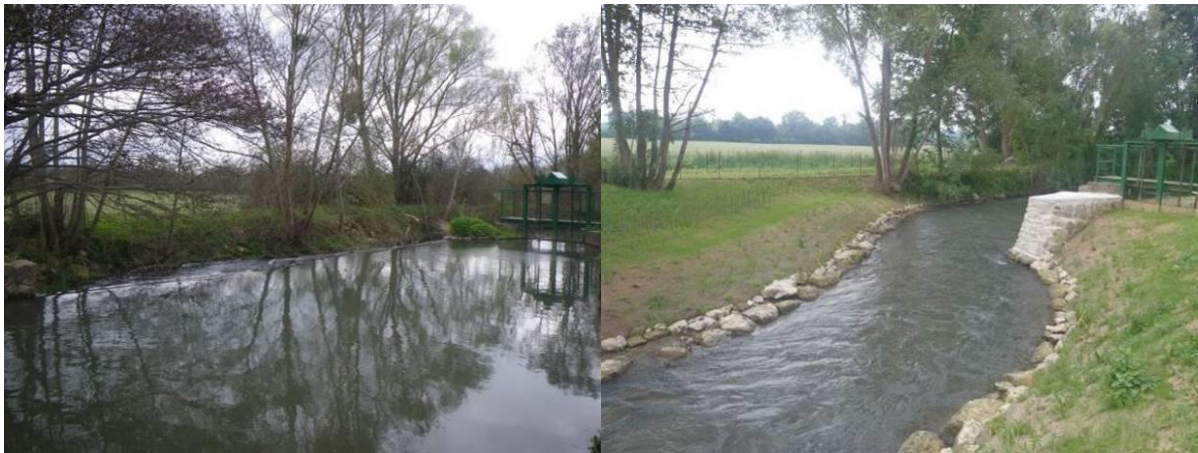
Photo 1 : Exemple d'effacement réalisé par SEGI au Moulin de Longpont situé sur la combe des Ormes-sur-Voulzie (77)
