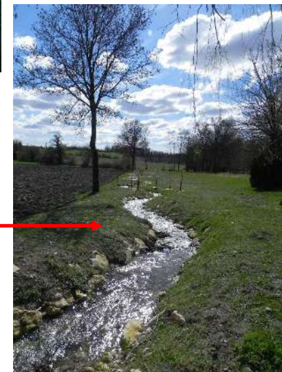
Création d'un bras de contournement d'environ 250 mètres de longueur pour récupérer une chute de moulin d'environ 4 mètres de hauteur
