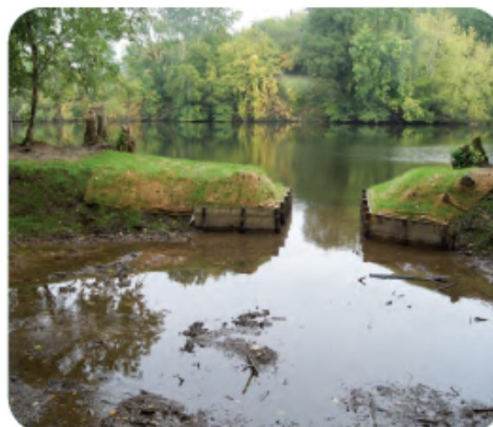
Reconnexion hydraulique et stabilisation de berges sur les sites des Bouysses dans le Lot (46).
