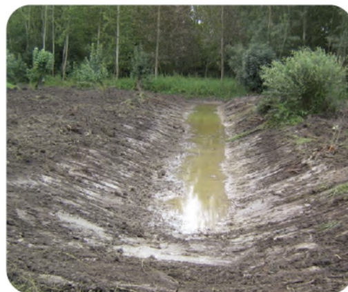
Rigole de ressuyage au moulin de Rouanne en Charente-Maritime (17).
